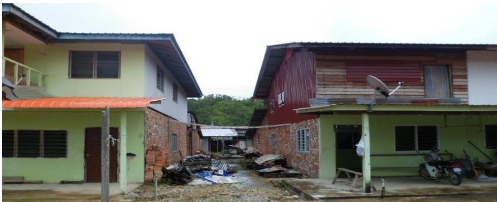
Gambar 4.39: Satu tapak bilik yang menyebabkan kebakaran berlaku pada tahun 2009 telah dikosongkan atas persetujuan semua penghuni rumah panjang setelah membina rumah yang baru.
