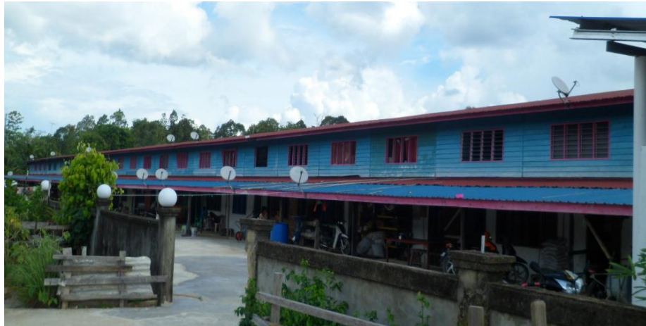
Gambar 4.36: Struktur Rumah Jabu yang baru dibina selepas mengalami kebakaran pada tahun 1989.
